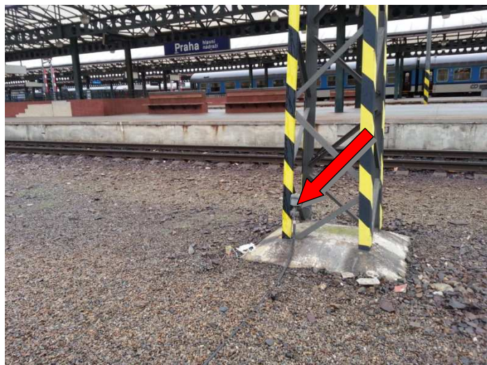
MB-2, Uzemnění sloupu mezi kolejemi
